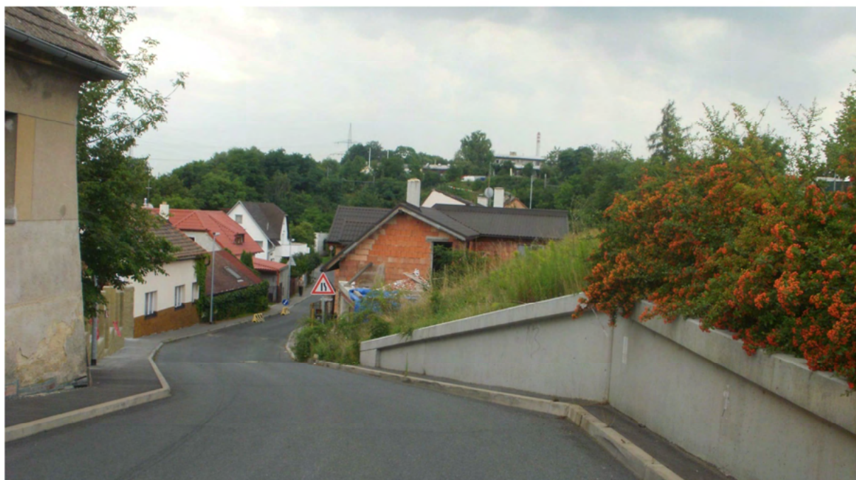
Obrázek 13: Ulice Hodějovská ve směru od ulice Broumarské
