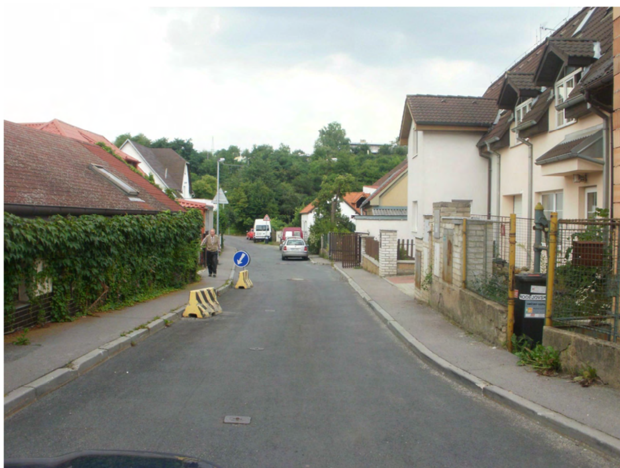
Obrázek 14: Ulice Hodějovská – nevhodně postavené betonové svodidlo
