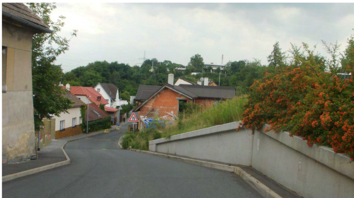
Obrázek 13: Ulice Hodějovská ve směru od ulice Broumarské
