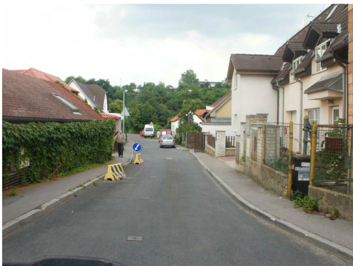
Obrázek 14: Ulice Hodějovská – nevhodně postavené betonové svodidlo
