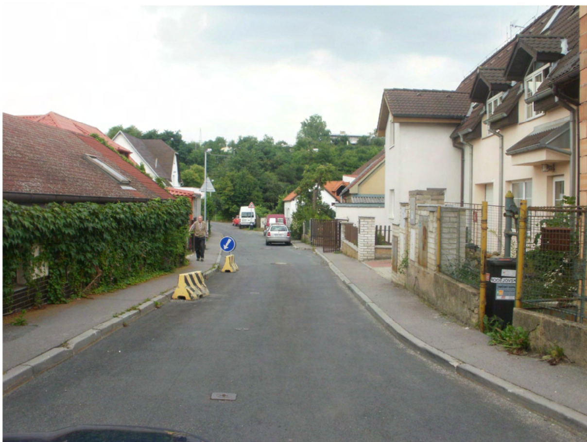
Obrázek 14: Ulice Hodějovská – nevhodně postavené betonové svodidlo
