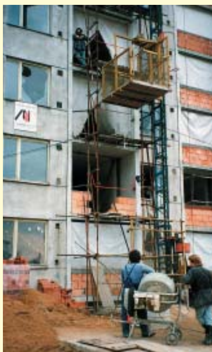
V roce 1995 započala náročná rekonstrukce panelového domu v ulici Bří Venclíků na sídlo radnice Prahy 14.
