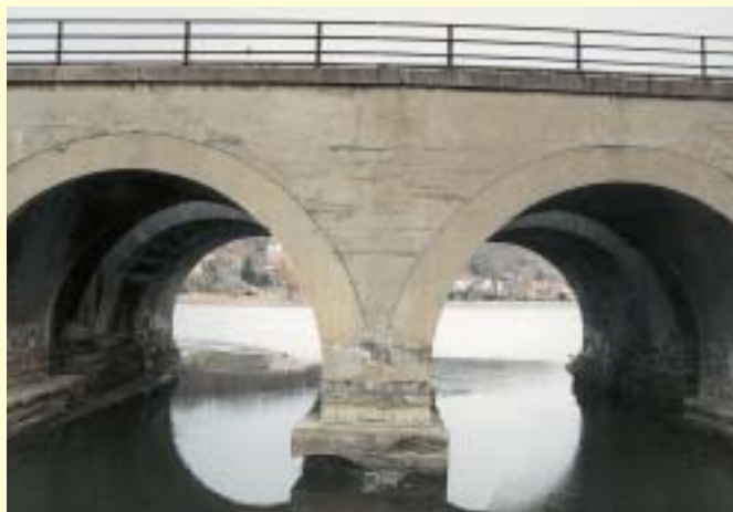
Oblast Kyjského rybníka průhledem viaduktu.
