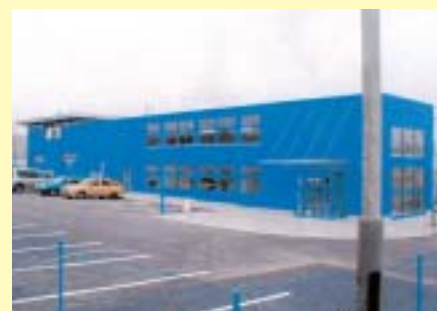
Pohled na nový objekt STK ze severní strany.
