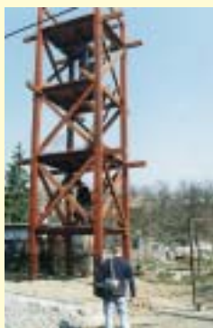
V dubnu bylo lanové centrum na Libeňském ostrově před dokončením.
