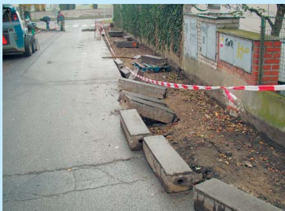
Výstavba chodníku o šířce 1,5 m v Kalištské ulici (stav k 21.11. 2005), foto: archiv
