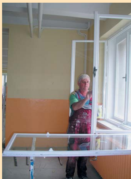
ZŠ Šimanovská - opravy a nátěry oken v jídelně
