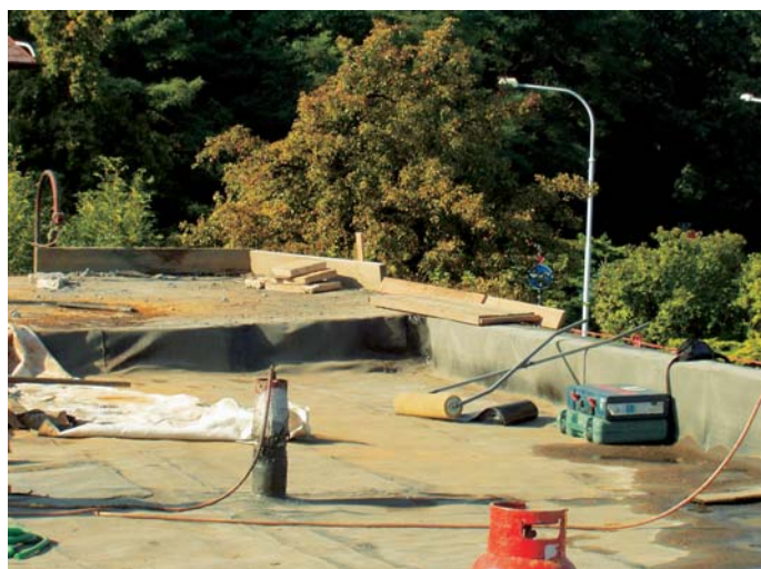
Částečné odkrytí horní vrstvy střechy MŠ Štolmířská v průběhu rekonstrukce
