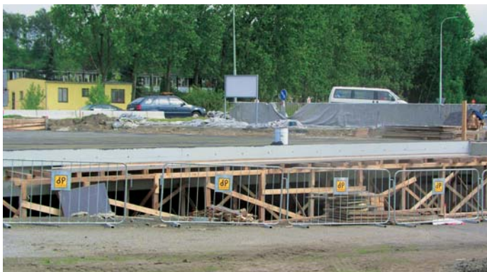
Budování podjezdu pod Chlumeckou ulicí
