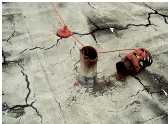
Vrchní vrstva střechy MŠ Štolmířská před rekonstrukcí
