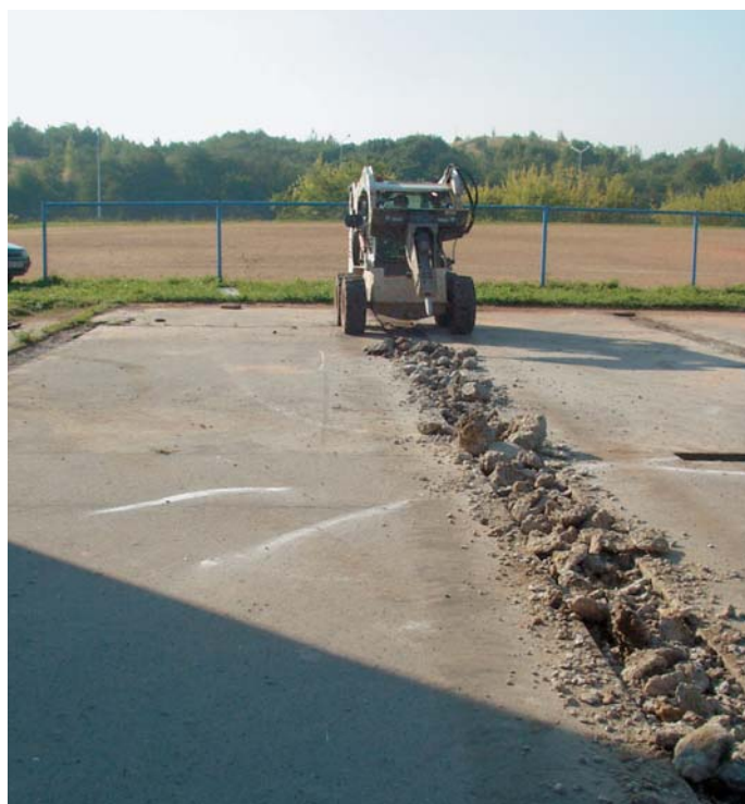
Zahájení prací na odvodnění víceúčelového hřiště při ZŠ Bratří Venclíků
