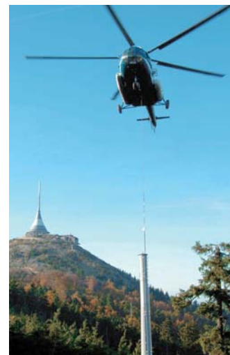
I takhle se budoval nový skiareál Ještěd.
