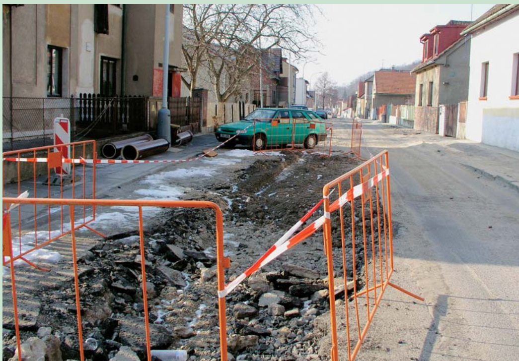
Rekonstrukce Tálínské ulice.
