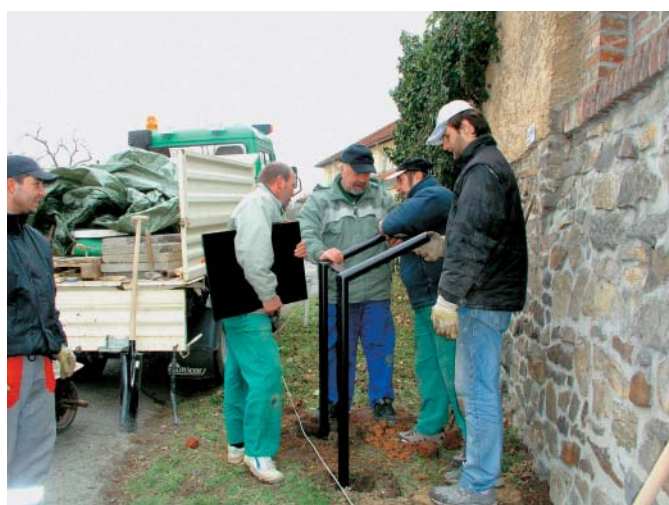
Stojany instalovali pracovníci hospodářské správy ÚMČ Praha 14.
