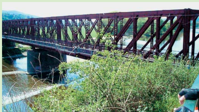
Železniční most s roštem pro pěší a cyklisty přes Berounku mezi Dolními a Horními Mokropsy.
