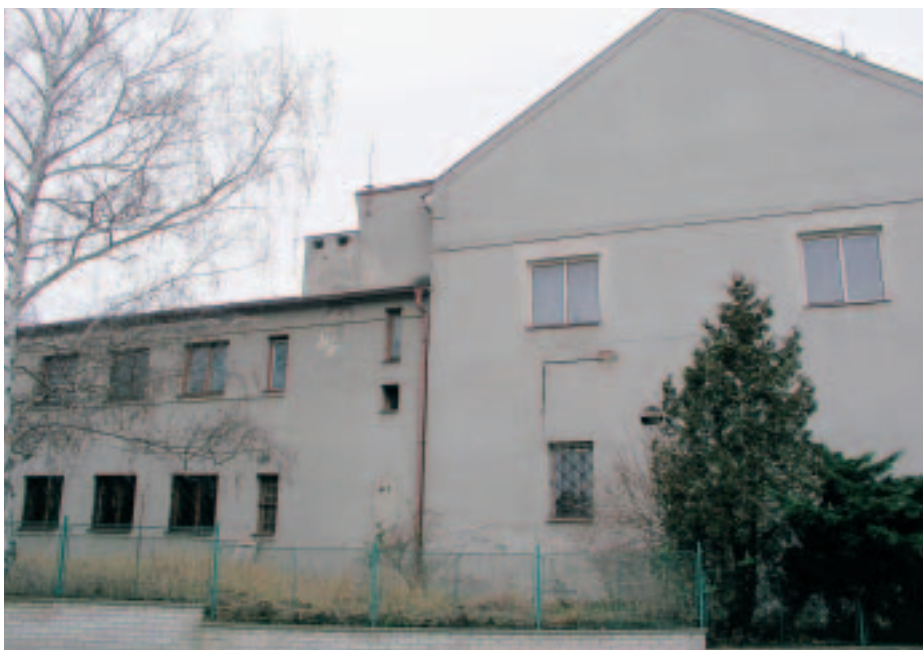
Současný stav objektu v Šimanovské ulici.
