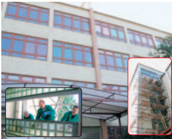
ZŠ Hloubětínská má mj. vyměněná okna a vstupní dveře.
