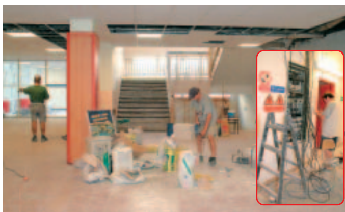
ZŠ Bří. Venclíků tři týdny před zahájením školy – kompletní výměna elektroinstalace, po níž následovalo malování.
