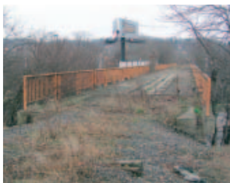
Trasa budoucí cyklostezky na bývalém železničním mostě. foto: vok
