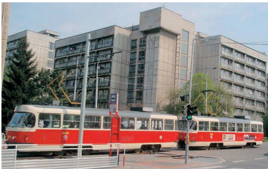
O čtrnáct dní dříve bylo vyměněno tramvajové těleso v Poděbratské ulici, kde na křižovatce s ulicí Slévačskou jsou nově instalovány semafony.
