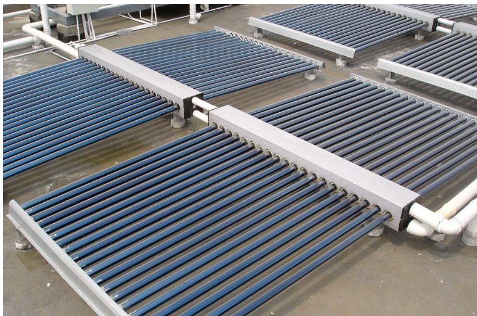
Obrázek 46 Solární trubicový kolektor
