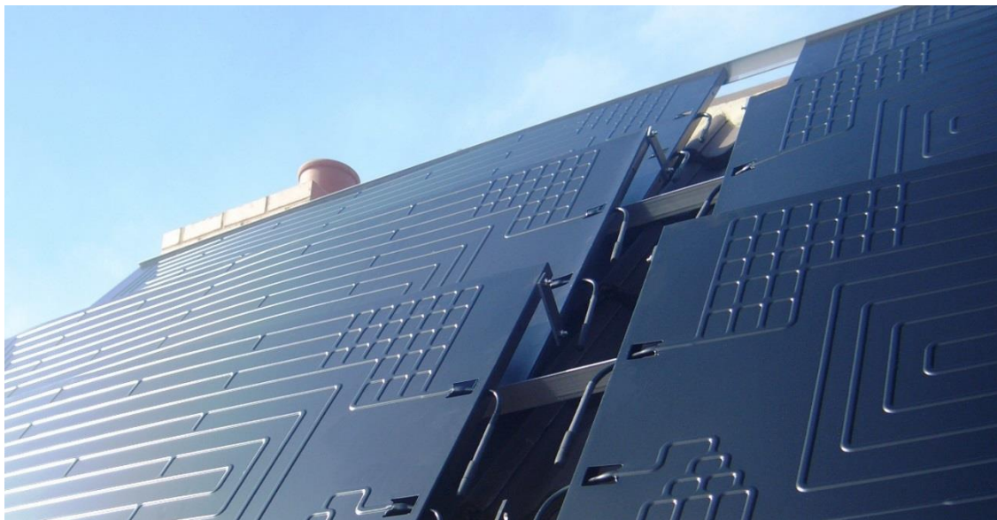
Obrázek 48 Detail termodynamických panelů
