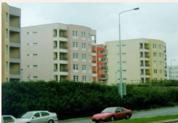
Poslední dva dokončené obytné domy 4. stavby naproti Hassu nabízejí třicet bytů, z nichž je šest bezbariérových.
