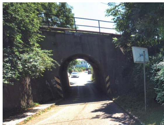
Obrázek 12 Podjezd v ulici K Viaduktu
