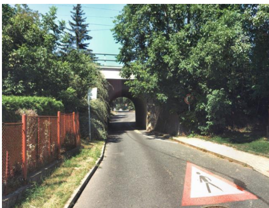
Obrázek 11 Podjezd v ulici K Viaduktu – jižní pohled
