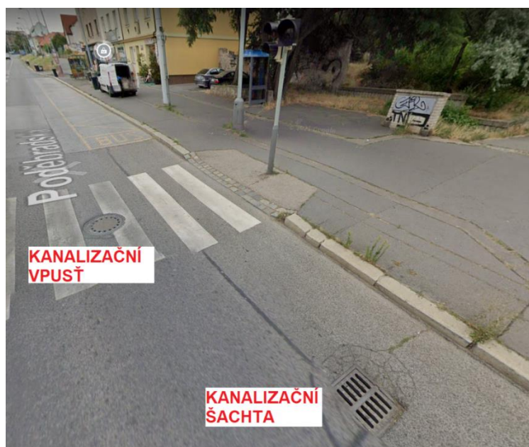
Obrázek 46: kanalizační vpust' a kanalizační šachta na fotce z Google Street View (ulice Poděbradská 50.1050047N, 14.5320153E)
