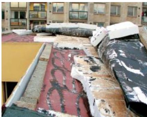
Poničená střecha objektu v Bojčenkově ulici, kde sídlí Dům sociálních služeb MČ Praha 14, provozovaný ČČK.
