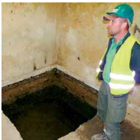
Tomáš Červenka u jímky se spodní vodou v místě, kde za pár měsíců bude kotelna a strojovna vzduchotechniky.
