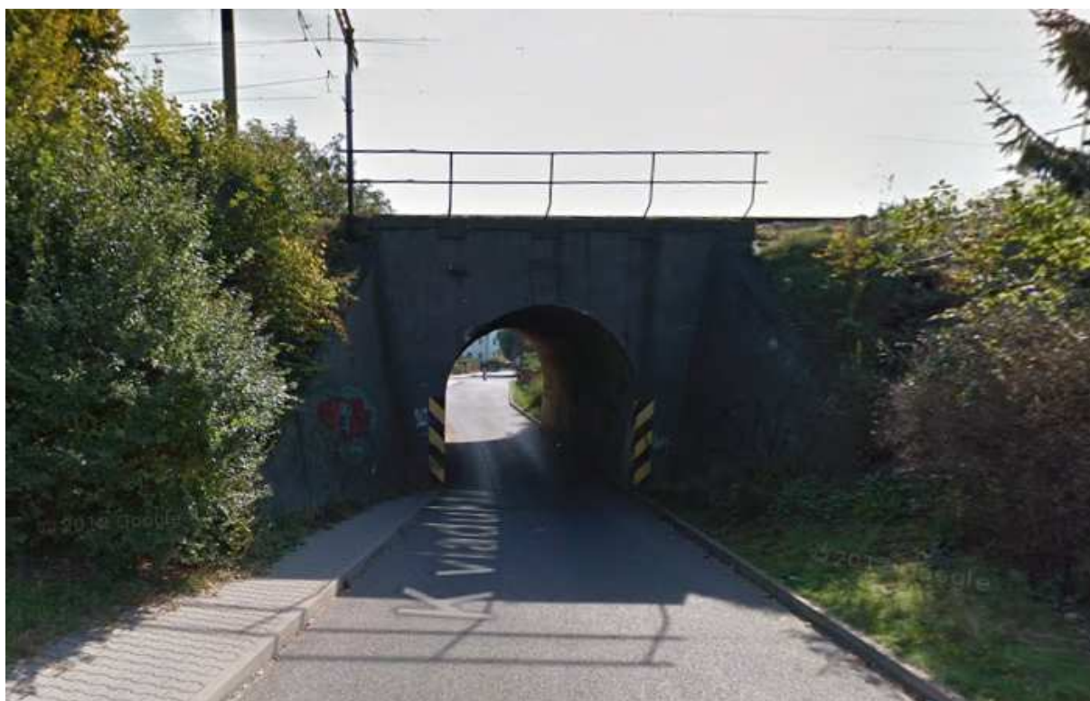
Obrázek 54 - Podjezd v ulici K Viaduktu - severní pohled
