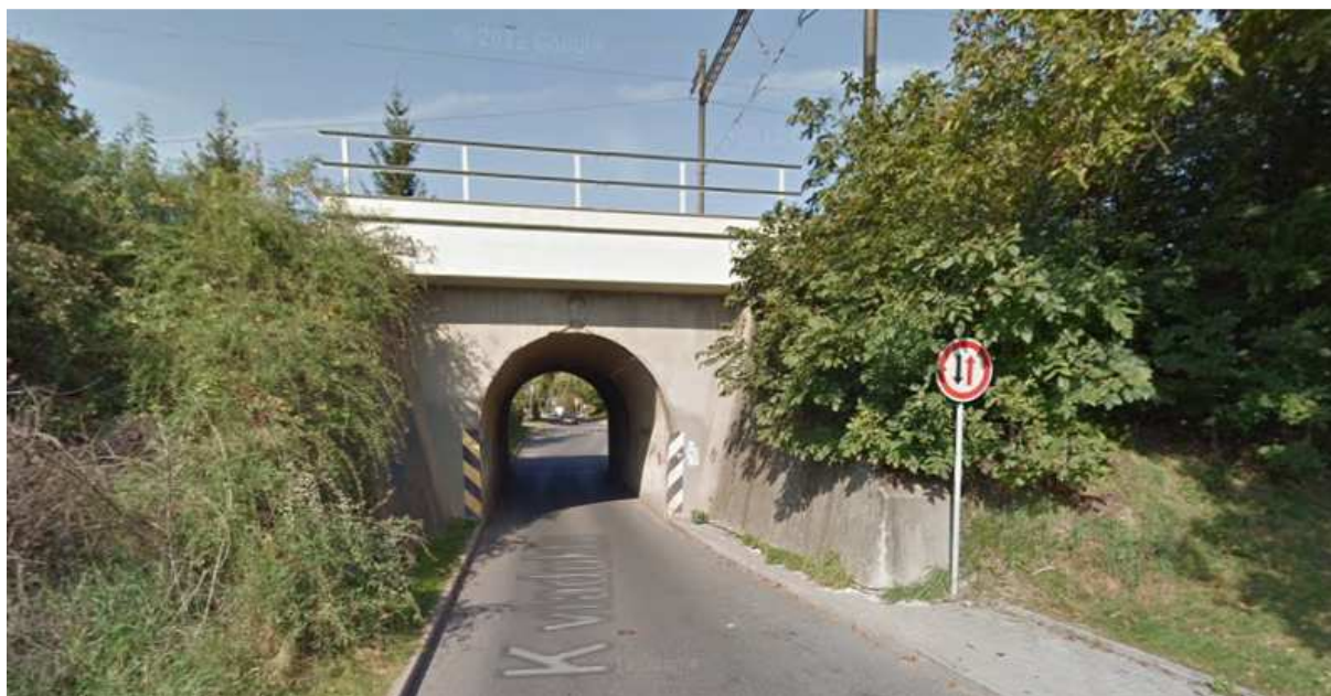
Obrázek 53 - Podjezd v ulici K Viaduktu - jižní pohled
