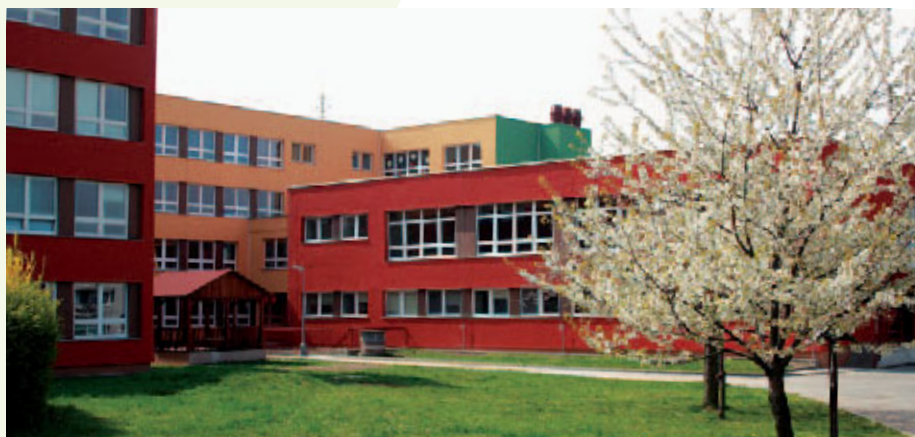
Vloni se dočkaly školy v Praze 14 zateplení a dalších důležitých oprav, v letošním roce chce radnice v investicích do školských objektů pokračovat.
