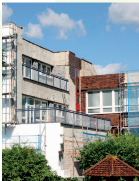
ZŠ Chvaletická v době rekonstrukce.
