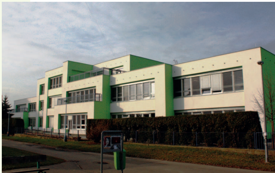
Dnes má ZŠ Chvaletická slušivou novou fasádu, která navíc šetří provozní náklady.
