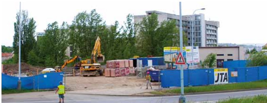
Na staveništi vedle tramvajové točny na Lehovci se pilně pracuje. Nový obchod má otevřít už v srpnu.
