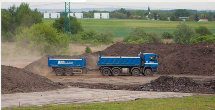
Vedení městské části si uvědomuje dočasnou zátěž související se stavbou parku a omlouvá se občanům za toto dočasné nepohodlí.
