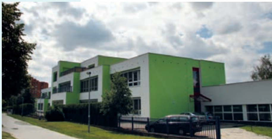
Jednou z významných investic MČ bylo zateplení budovy ZŠ Chvaletická na Lehovci.
