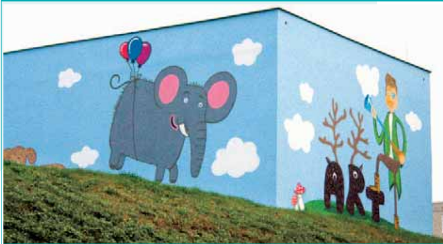
Jedna z trafostanic PRE na Černém Mostě byla vyzdobena mladými umělci...
