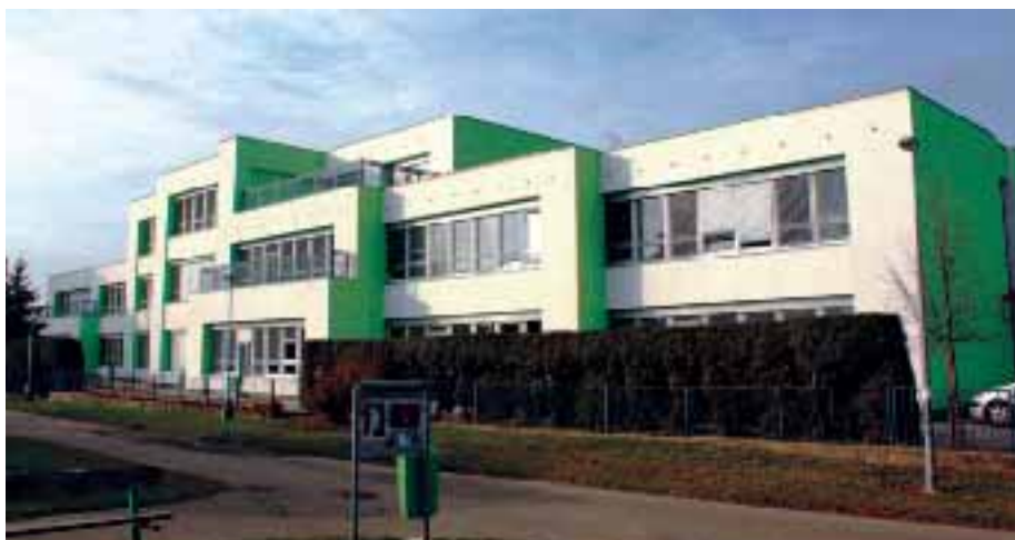
V budově ZŠ Chvaletická byly o prázdninách vyměněny podhledy, nové vybavení dostala i jídelna.
