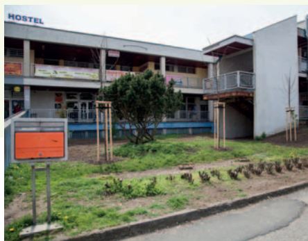
Prostor před poštou na Rajske zahradě po obnově.
