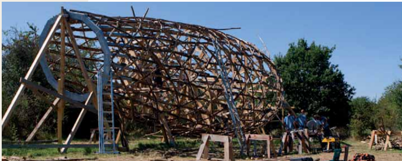
Rozhledna vzniká přímo na místě, kde bude vztyčena. Na snímku je první z trojice nohou, která byla v době uzávěrky téměř dokončená.
