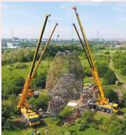
Foto: Huť architektury
