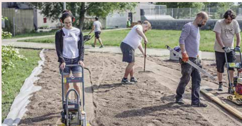
Budování odpočinku v Divočíně
