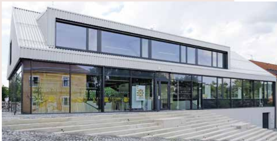
Prosklené stěny odráží okolní stavby a zeleň
