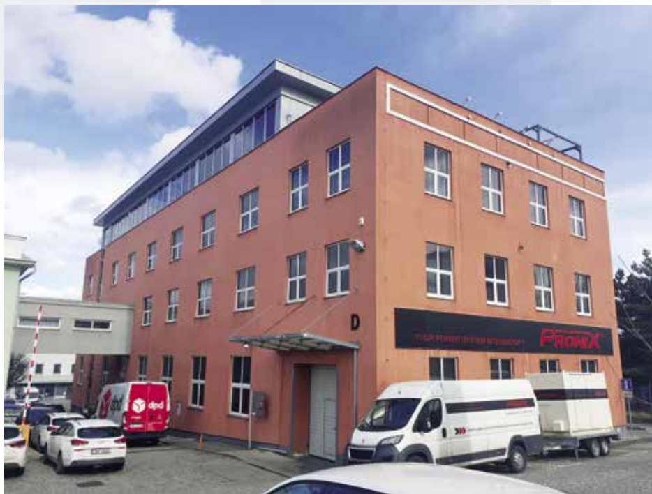
Část radnice Prahy 14 se dočasně přestěhuje do Hloubětína – Poděbradská 88/5.
