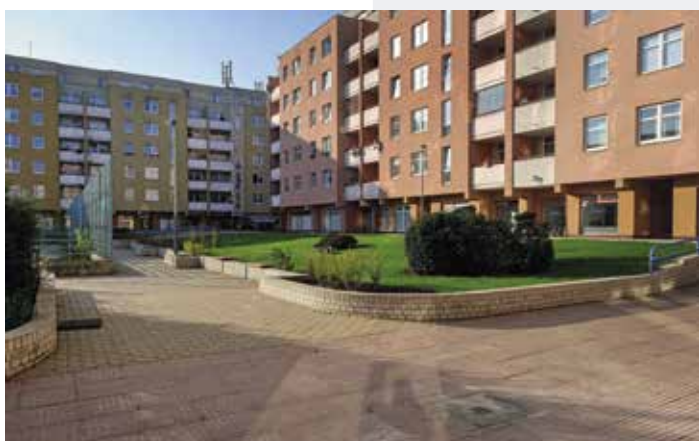
Vnitroblok F-G. Do budoucna se počítá i s úpravou plochy s tenisovými kurty
