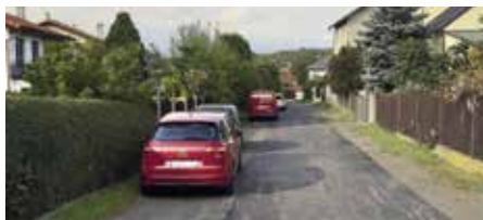
Opravená ulice Matenská
