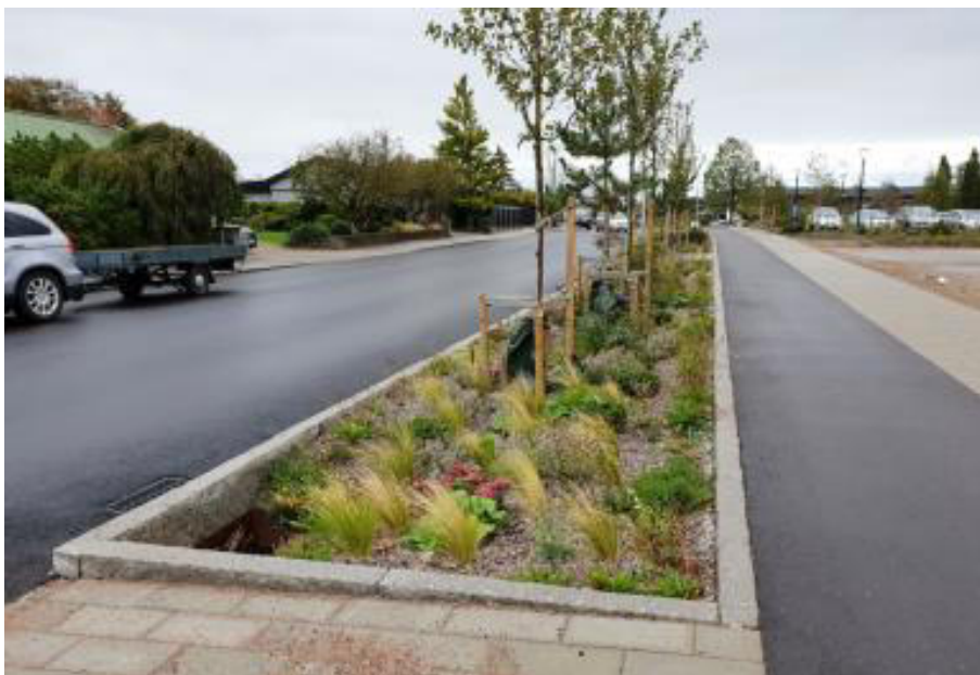
Prostor pro vsakování dešťové vody. Zdroj: Livable Streets - A Handbook of Bluegreengrey Systems Version 2.0
