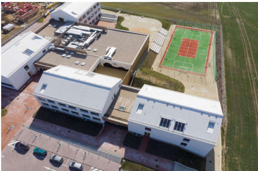
Světlé střechy. ( https://www.asb-portal.cz/stavebnictvi/strecha/stresni-krytina/plechova-krytina/proc-se-bila-barva-strech-stane-mozna-stejne-oblibena-jako-u-aut )
