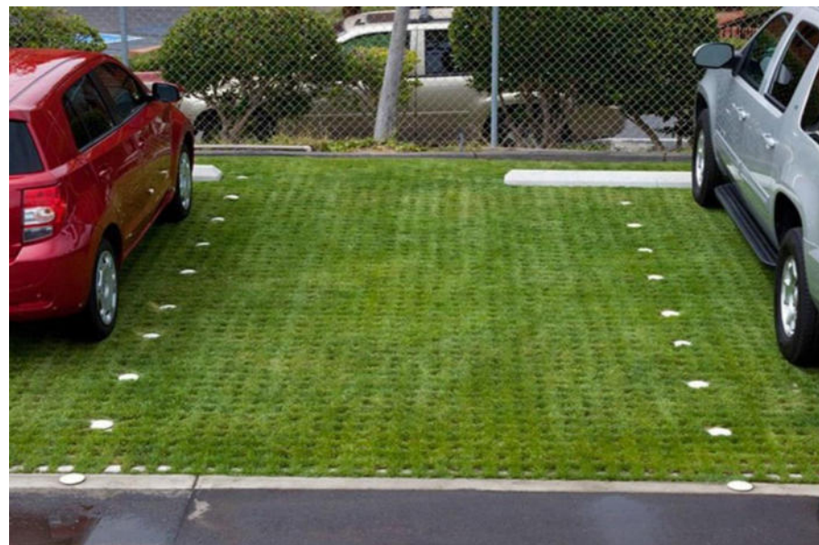
Zatravněvací tvárnice Guttargarten – realizace ( https://www.guttashop.cz/zatravnovaci-tvarnice-guttargarten-.7809/ )
