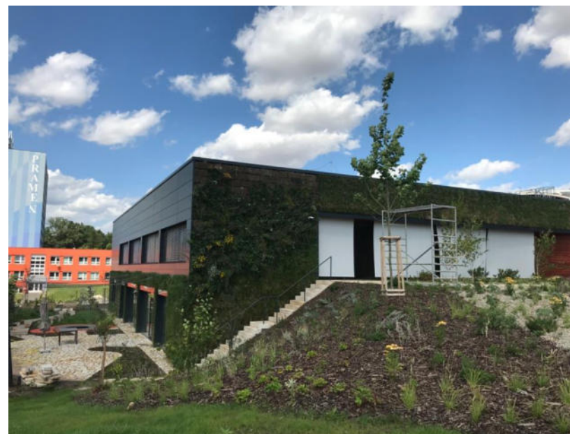
Příklad budovy adaptované na změnu klimatu, ulice Za Černým Mostem (Foto: Foto: CI2, o. p. s.)
