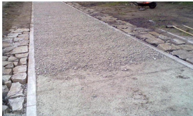
Mlatový povrch. ( https://www.msstavby.cz/mlatove-komunikace-u-ostavice-05-09-2012/ )
