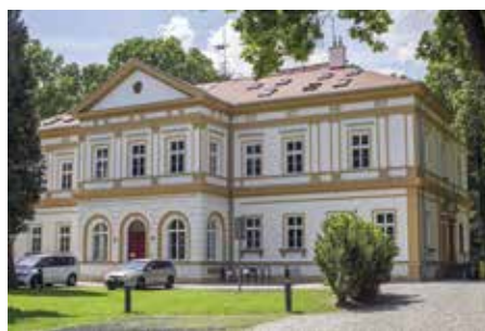
Střechu zámku v Hostavích čeká rekonstrukce Foto: archiv MČ Praha 14
