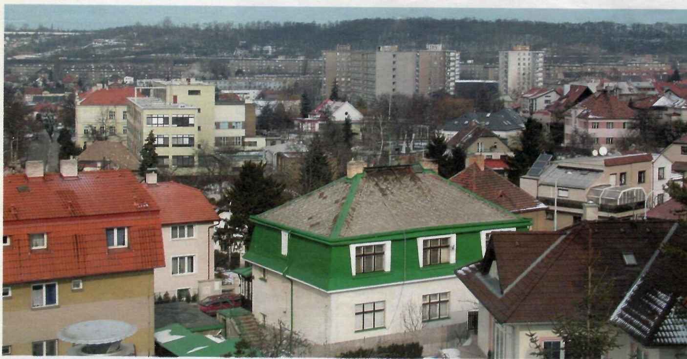
POHLED NA ZIMNÍ HLOUBĚTÍN.
