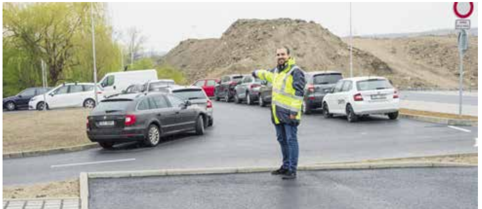
Radní pro dopravu Ing. Tomáš Novotný ukazuje nově budované obratiště linky 223 v Brykově ulici
