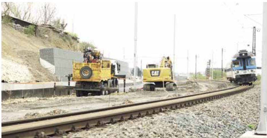
Nově budovaná železniční zastávka Rajska zahrada
