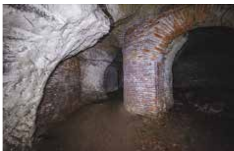
Zachovalé cihlové zdi.
