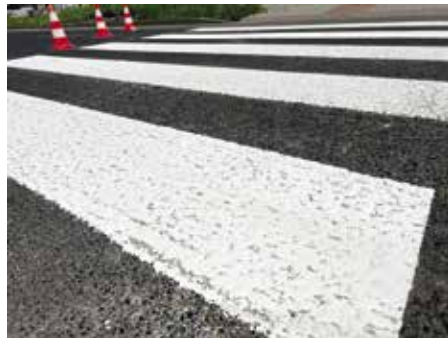
Praha 14 realizuje bezpečnější, lépe viditelné přechody, malované reflexní barvou. Tento je nový v Hostavicích
