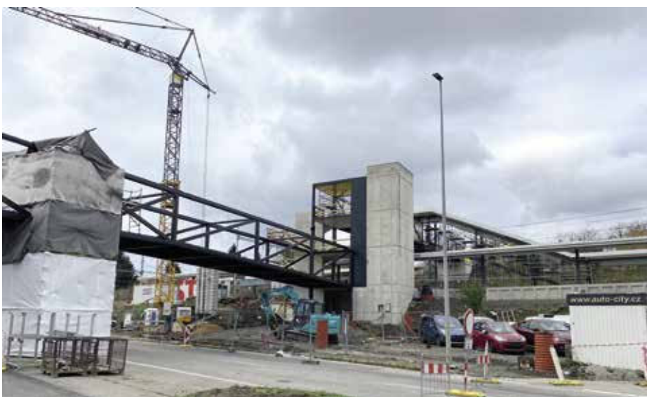
V listopadu 2023 byla položena část lávky přes ulici Chlumecká
