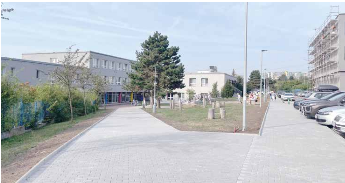
Nově opravený prostor před ZŠ Bratří Venclíků
