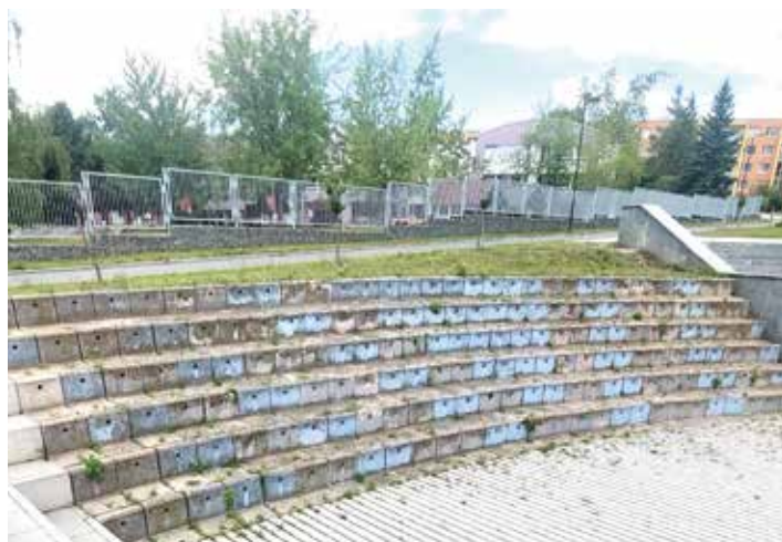
Schodiště v areálu ZŠ Vybíralova na Černém Mostě před a po opravě
