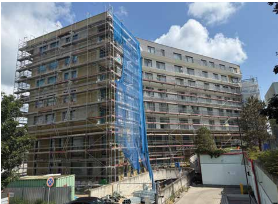
Aktuálně probíhají práce mimo jiné na zateplení fasády...
