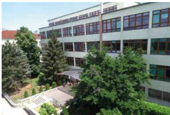
Budova ZŠ Hloubětínská
