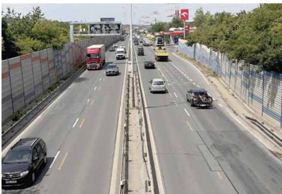
Kbelská volá po opravě dlouho. Dočká se jí o prázdninách
