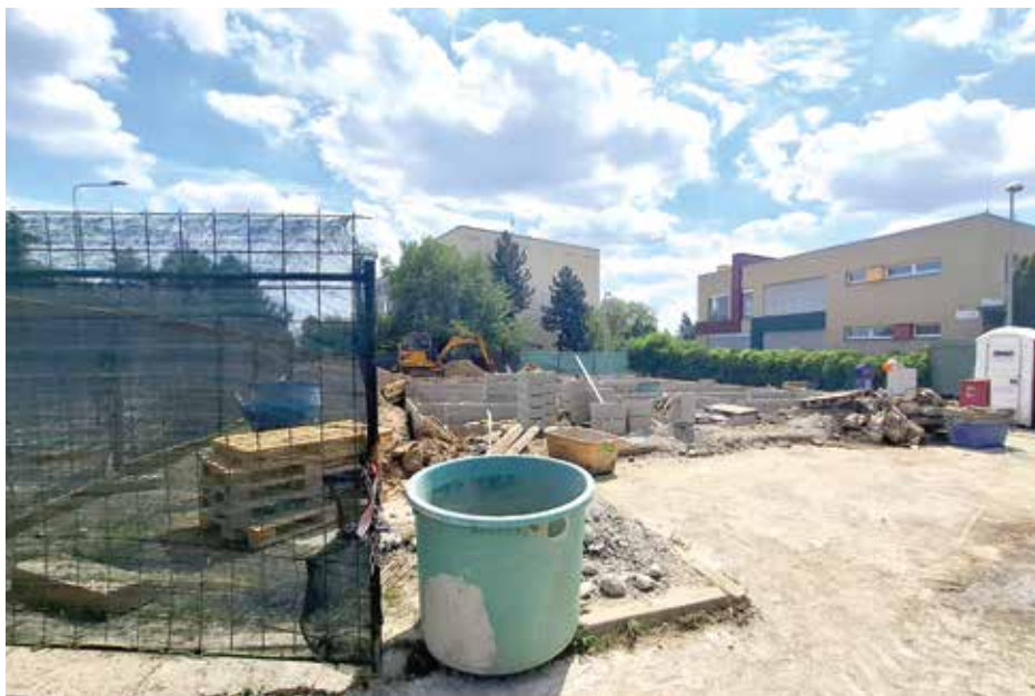
Na výstavbě dočasné základní školy v ulici Travná se aktuálně intenzivně pracuje Foto: Kateřina Zajacová
